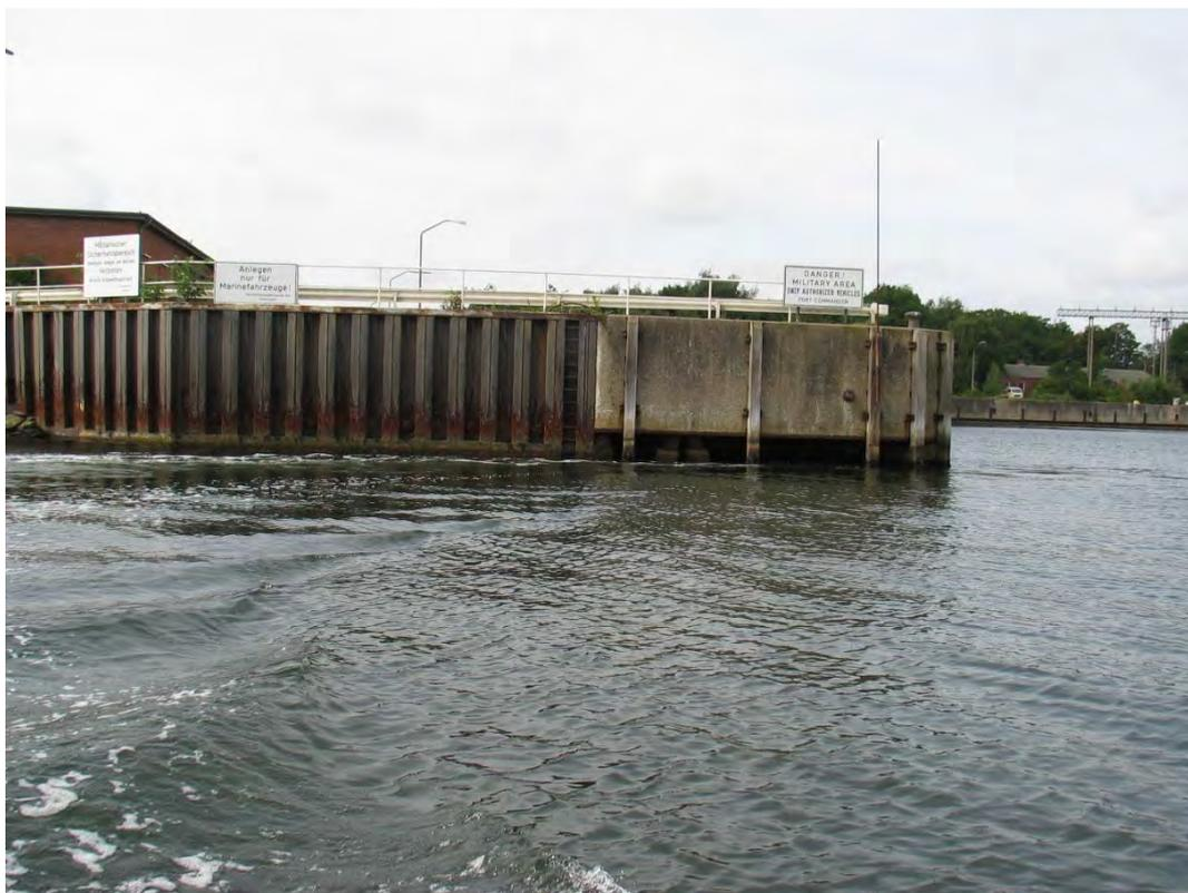
**Foto 20: Südöstlicher Eckbereich und Abschlusspundwand**
