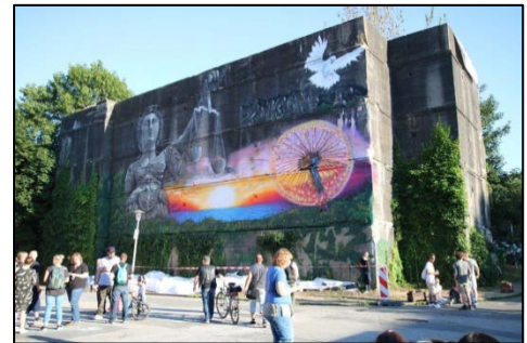
Bunker im Sandkrugquartier
