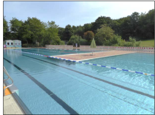
Das neue Schwimmbecken im Sommerbad Katzheide
