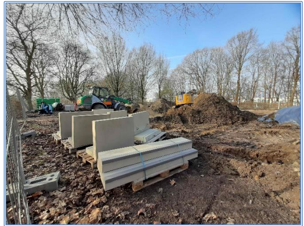
Bauarbeiten am neuen Bolzplatz im Werftpark (Februar 2023)
