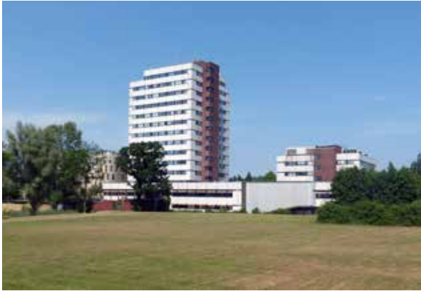
Das Biologiezentrum ist extrem sanierungsbedürftig und erfüllt nicht mehr die Anforderungen der Institute.
