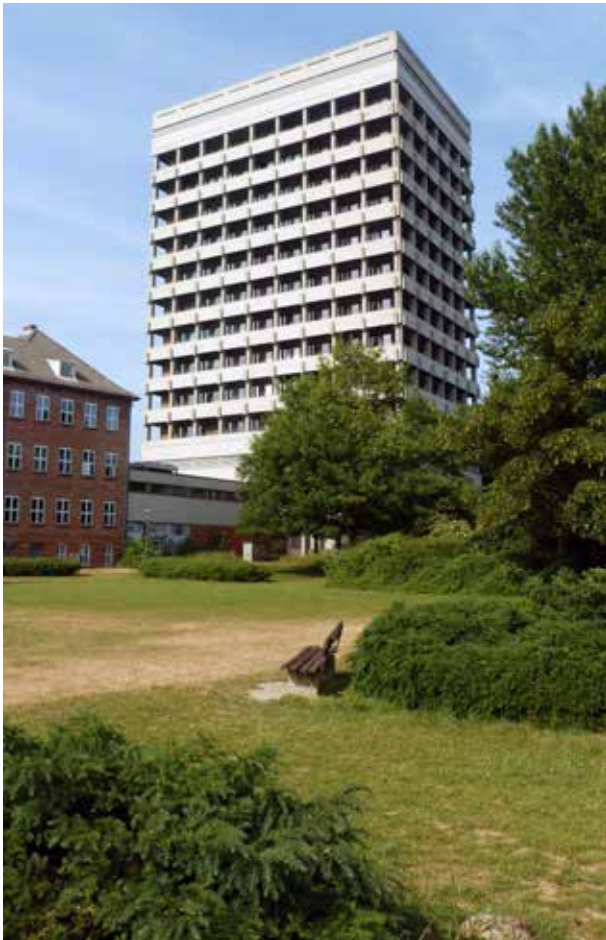
Das sanierungsbedürftige Bestandsgebäude des Max Rubner-Instituts im Kieler Innenstadtgebiet.
