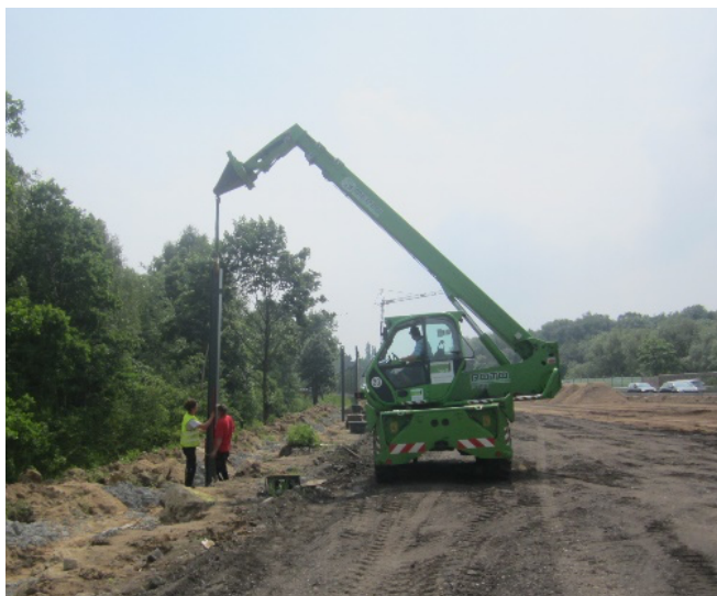
Bild 7: Aufstellen der Stützen
