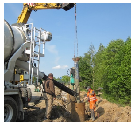
Bild 4: Einbringen des Betons
