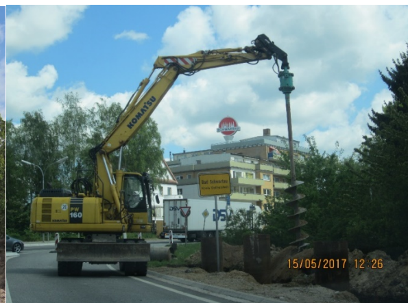
Bild 2: Ausbohren des Stützrohrs
