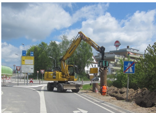
Bild 1: Einbringung Stützrohr
