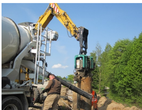
Bild 5: Ziehen des Stützrohrs
