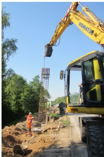
Bild 3: Einbringen des Bewehrungs-Korbs
