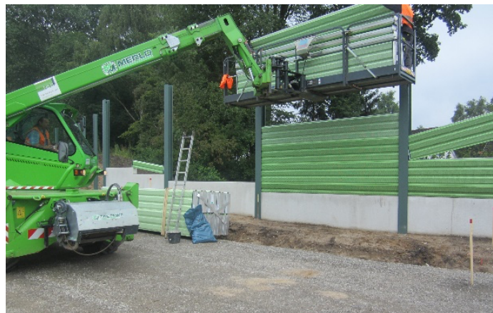
Bild 9:Montage der Wandelemente aus Aluminium
