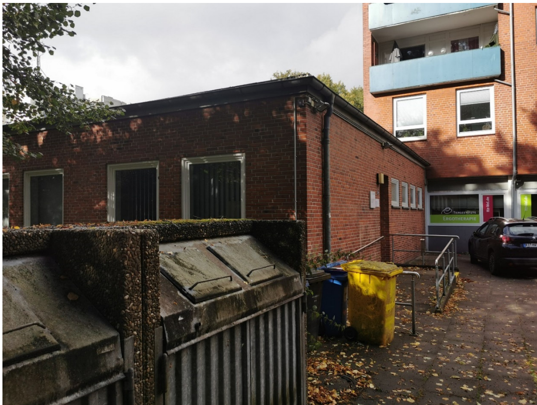
Abbildung 11: Südöstlicher Gebäudeteil der Stadtteilbücherei
