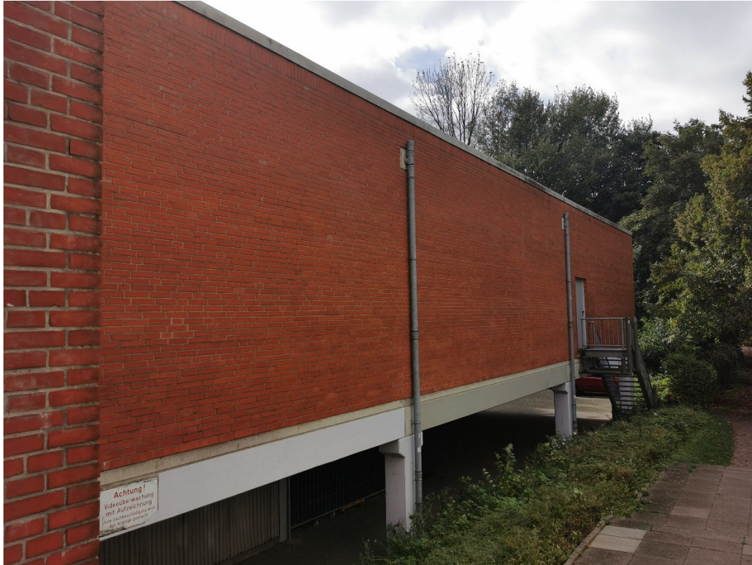
Abbildung 6: Nordfassade des REWE-Marktes, hinterer Teil
