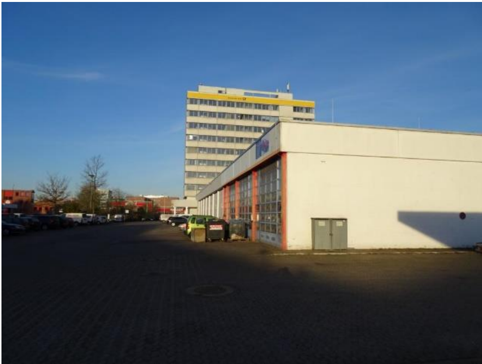
Abbildung 5: Gebäude 3, bestehend aus eingeschossigen Hallen/ Garagen und dem im Hintergrund zu sehenden Hochhaus
