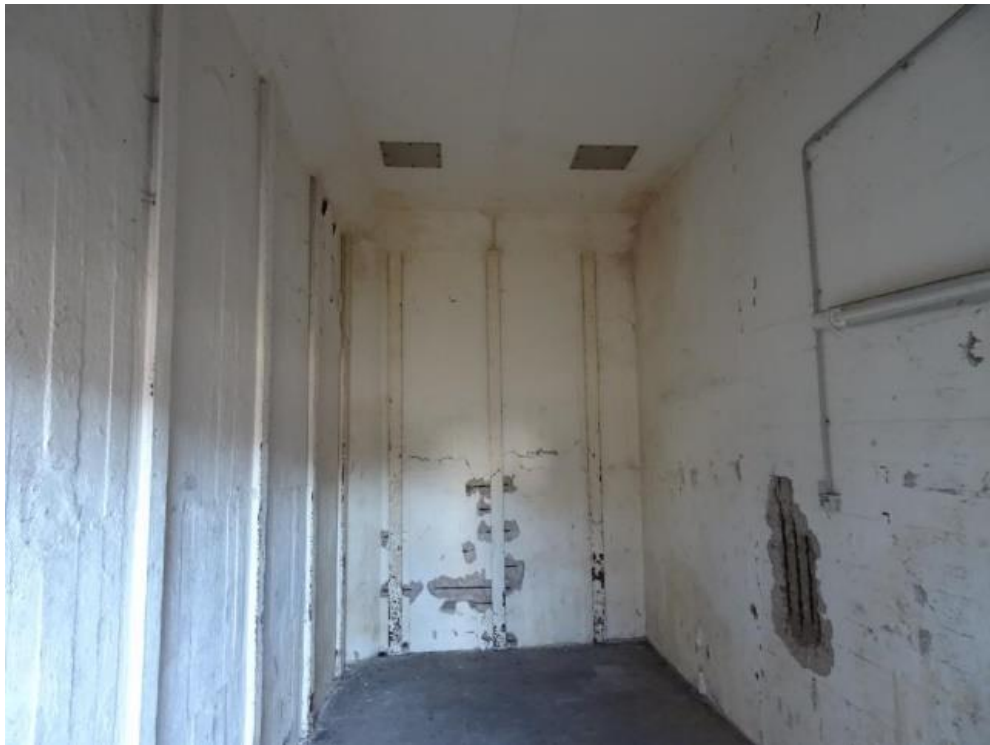
Abbildung 9: Nördlicher (Bunker-)Raum (Gebäude 7)
