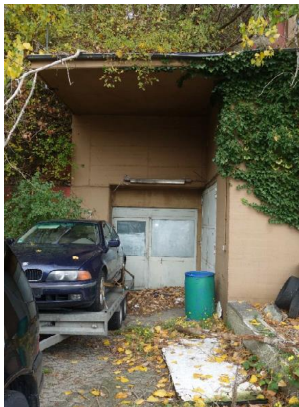
Abbildung 8: Eingänge zu den Bunkerräumen (Gebäude 7)
