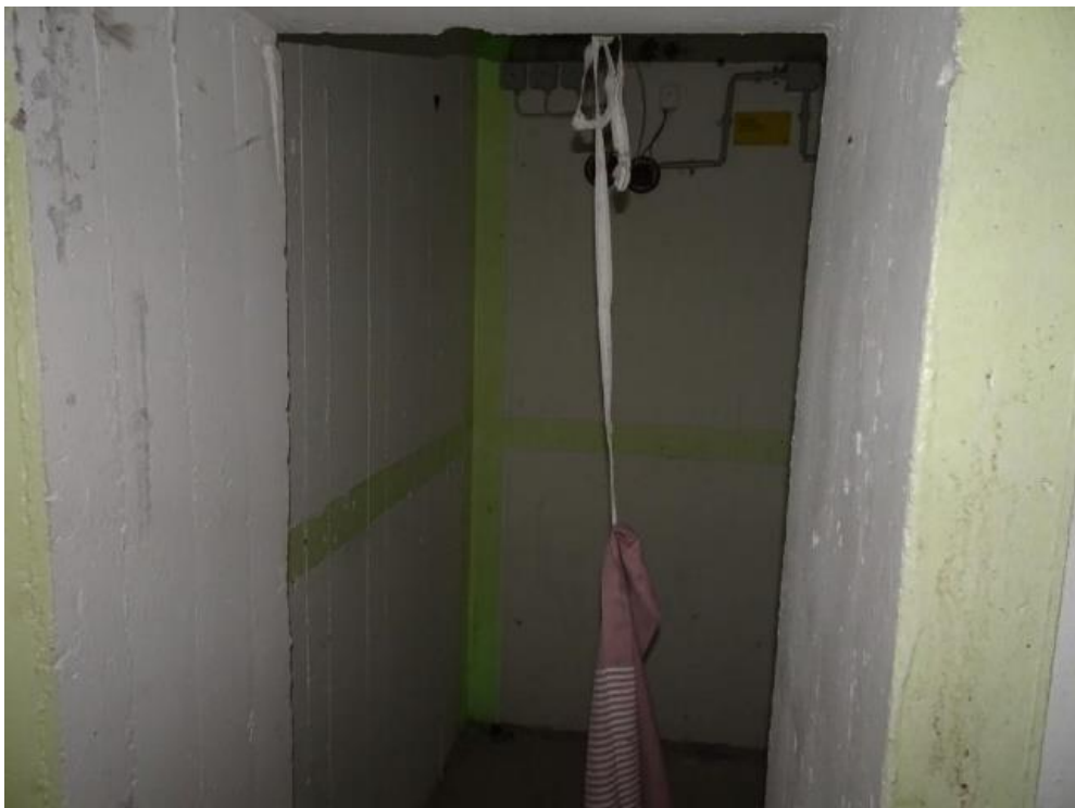
Abbildung 14: Bunkerraum unter dem Parkdeck. Vollverputzt, aber tendenziell als Winterquartier geeignet
