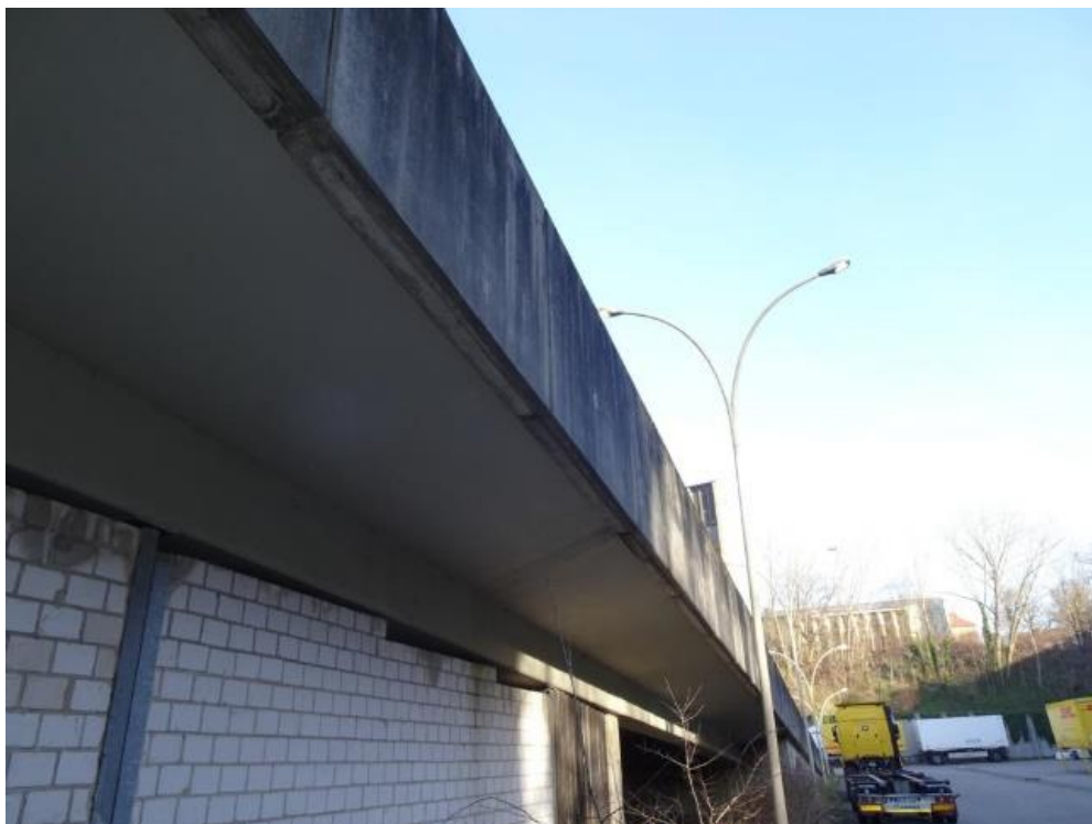
Abbildung 12: Auffahrtrampe zum Parkdeck (Sonderstruktur b)
