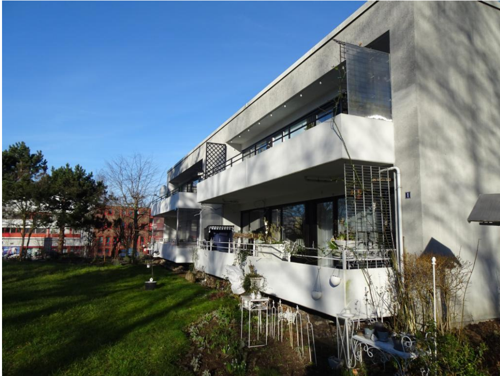
Abbildung 3: Südseite des Gebäude 1 mit Balkonen
