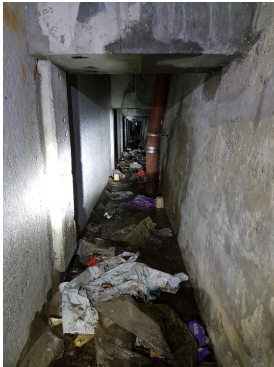
Abbildung 11: Kriechgang hinter nördlicher Spundwand (Sonderstruktur a)
