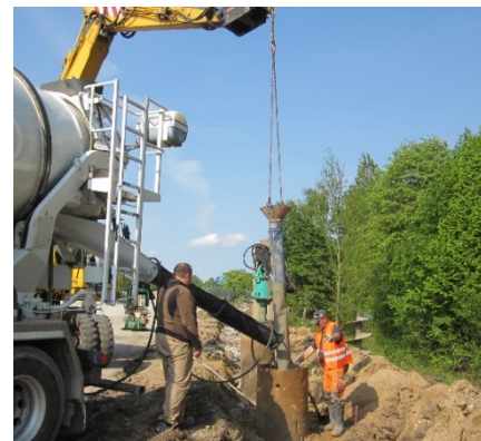
Bild 4: Einbringen des Betons
