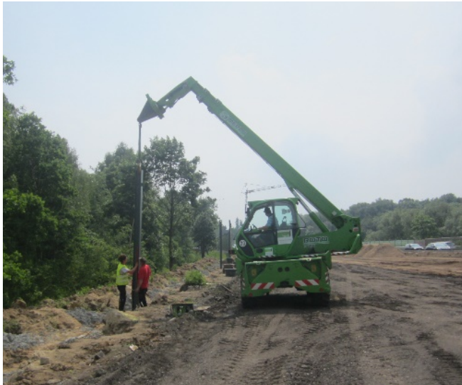
Bild 7: Aufstellen der Stützen
