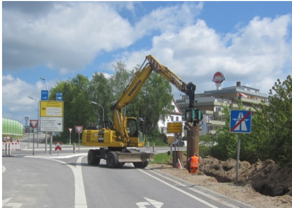
Bild 1: Einbringung Stützrohr
