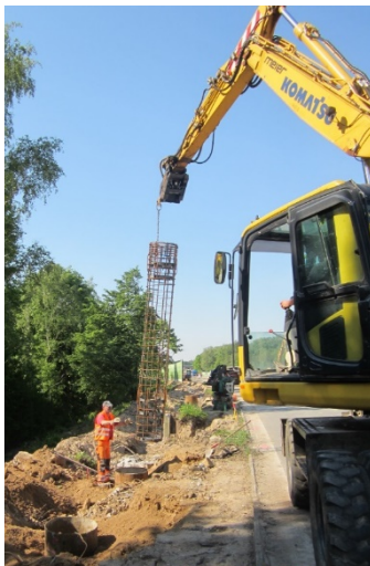
Bild 3: Einbringen des Bewehrungskorbs
