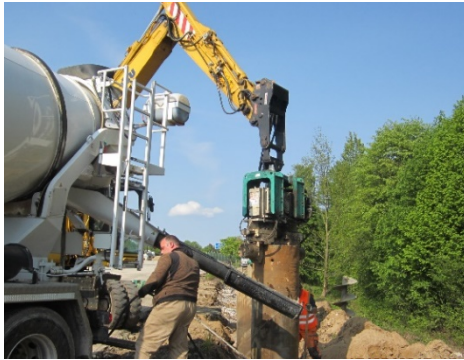
Bild 5: Ziehen des Stützrohrs
