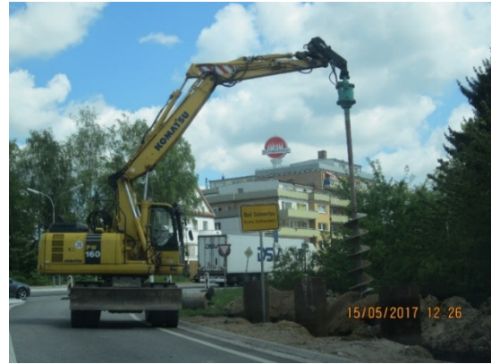
Bild 2: Ausbohren des Stützrohrs
