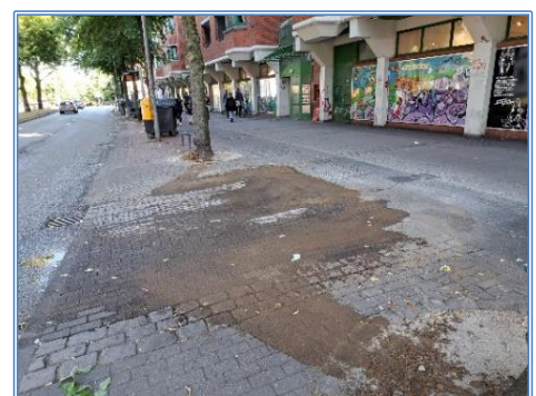
Bushaltestelle am Karlstal jetzt ohne Wartehäuschen; im Hintergrund das neue Bild
