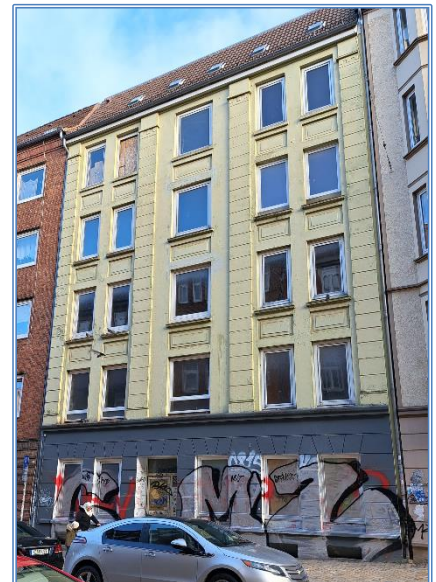
Offensichtlich leerstehendes Mehrfamilienhaus in der Iltisstraße
