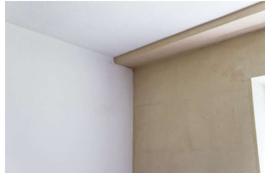
Bild 3 noch nicht gestrichene Innendämmung
